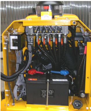
Abb. 13 - Raum mit der Batterie unter der hinteren Haube oben mit Not-Aus-Taster
